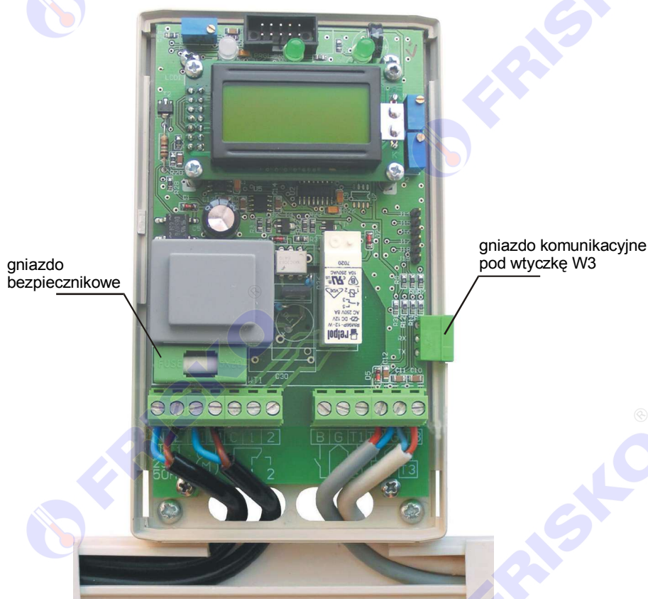
Montaż z użyciem dystansów, przewody prowadzone w korytku
