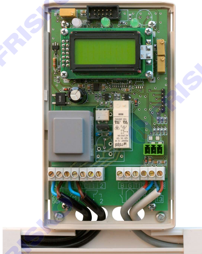
Montaż z użyciem dystansów, przewody prowadzone w korytku
